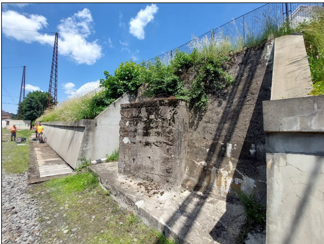
Obr. č. 15 - pohled na prostřední výklenek s torzem trakční podpěry
