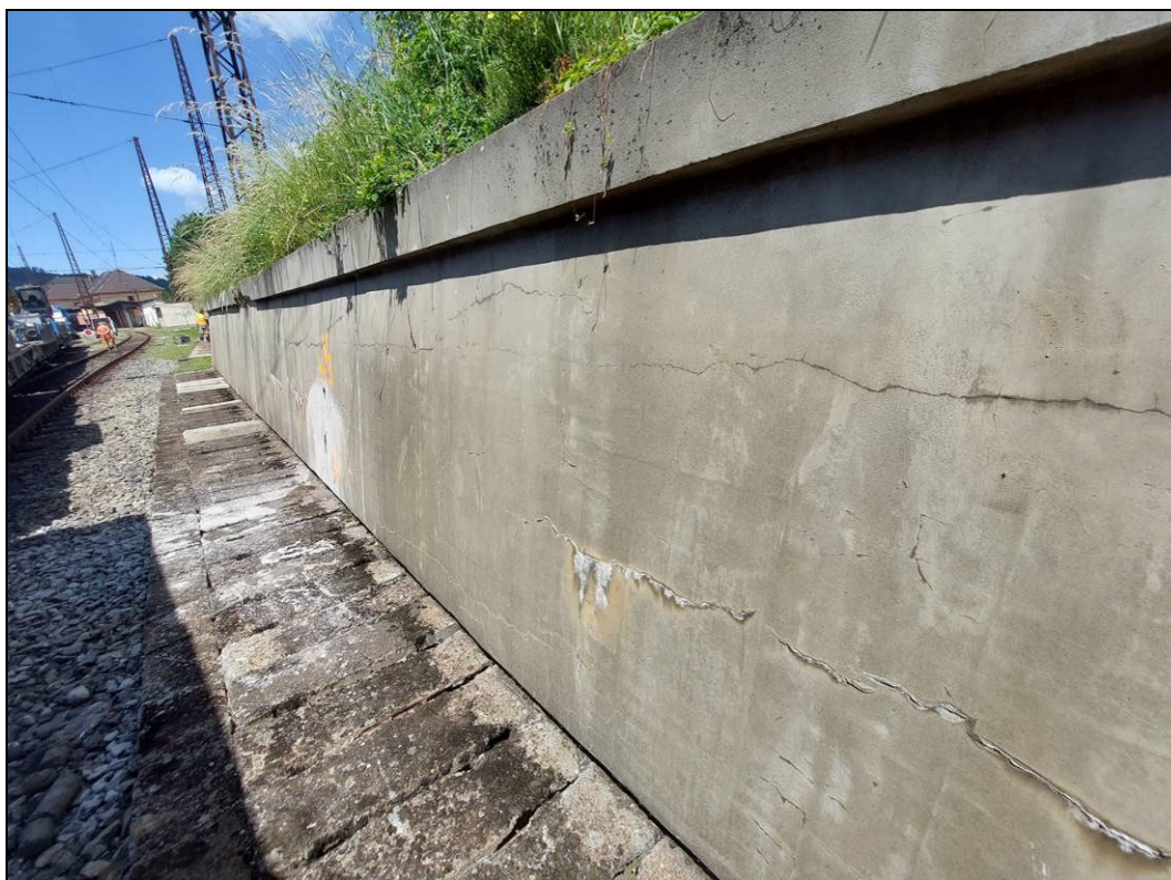
Obr. č. 8 - pohled na dřík zdi s vodorovnými vlasovými trhlinami v líci
