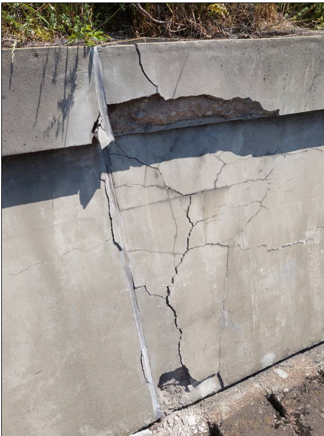
Obr. č. 14 - pohled na opady omítky způsobené degradací, resp. korozí podkladního betonu pravděpodobně vlivem dlouhodobých průsaku a klimatických změn
