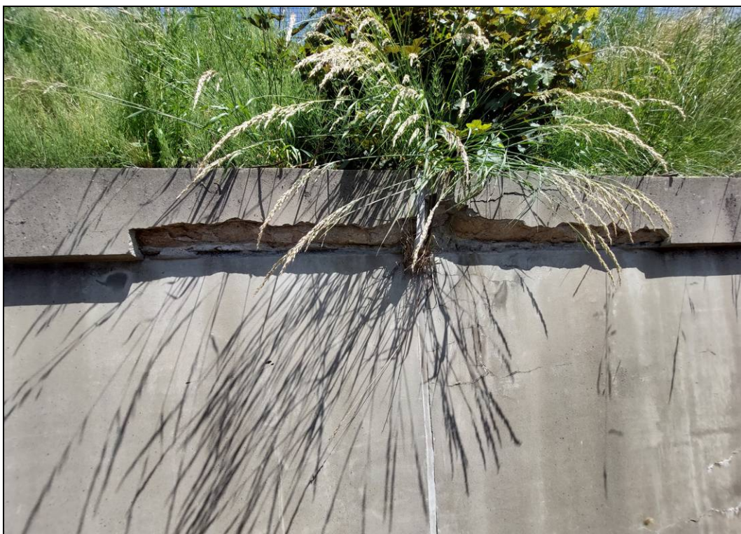
Obr. č. 12 - pohled na opady omítky a betonu římsy zdi
