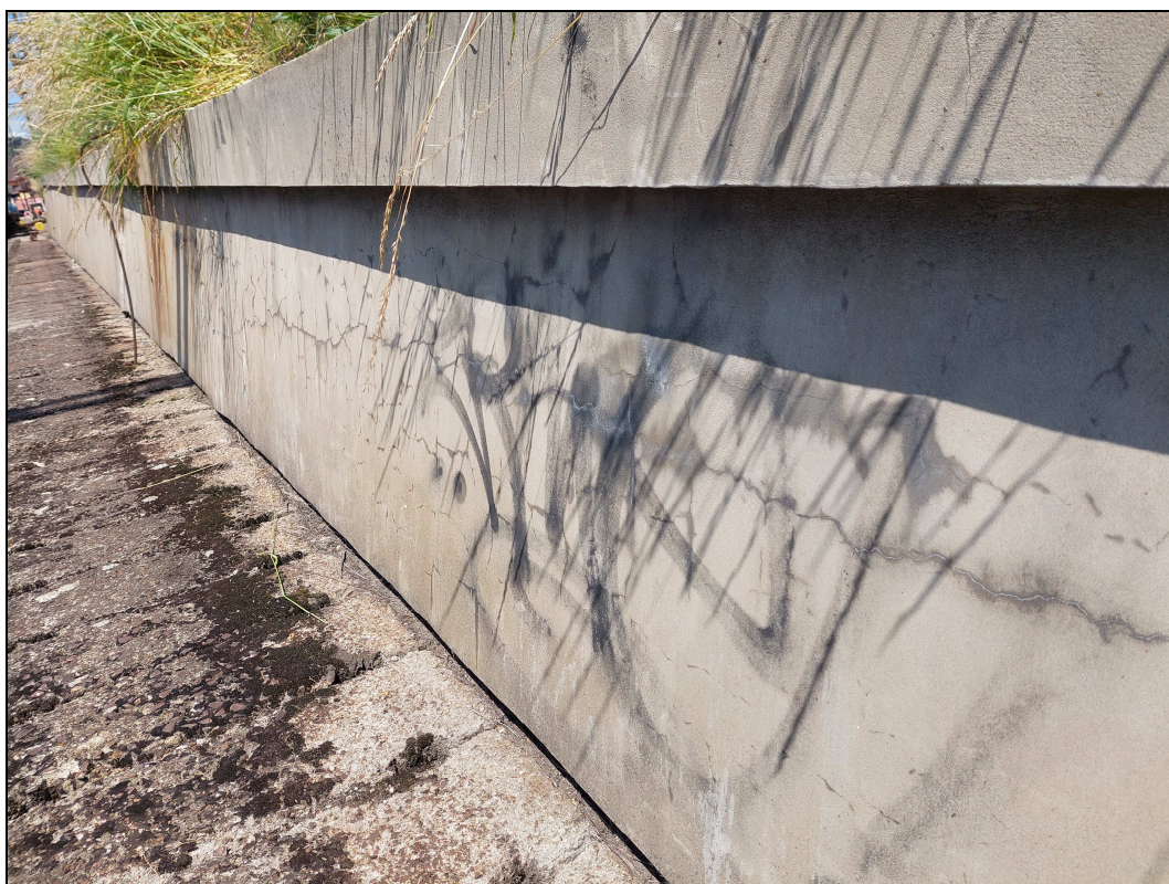
Obr. č. 13 - pohled na vlasové trhliny v líci zárubní zdi
