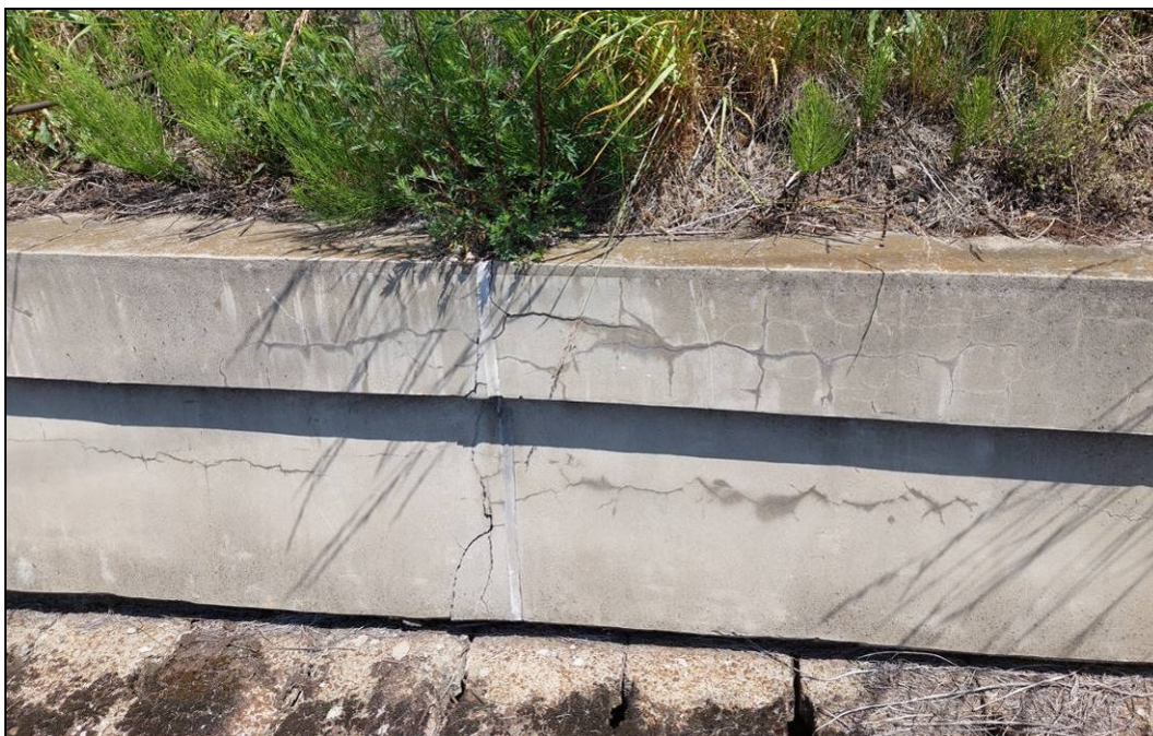
Obr. č. 11 - pohled na dřík zdi s vlasovými trhlinami
