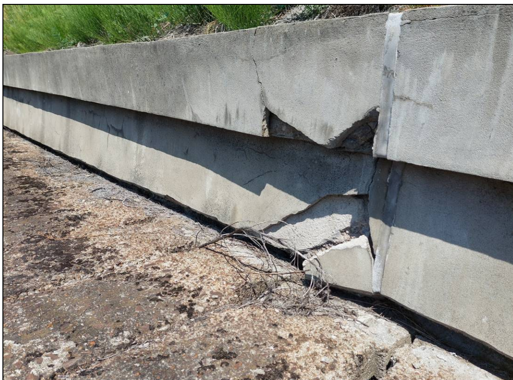
Obr. č. 10 - pohled na opady omítky v okolí dilatační spáry
